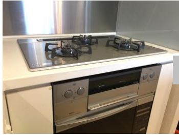
▲実際の施工後の写真 M様邸にてLiSSeの 交換工事
