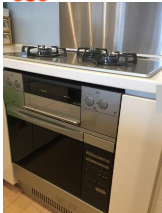
▲実際の施工後の写真 M様邸にてオーブンレンジ の交換工事
